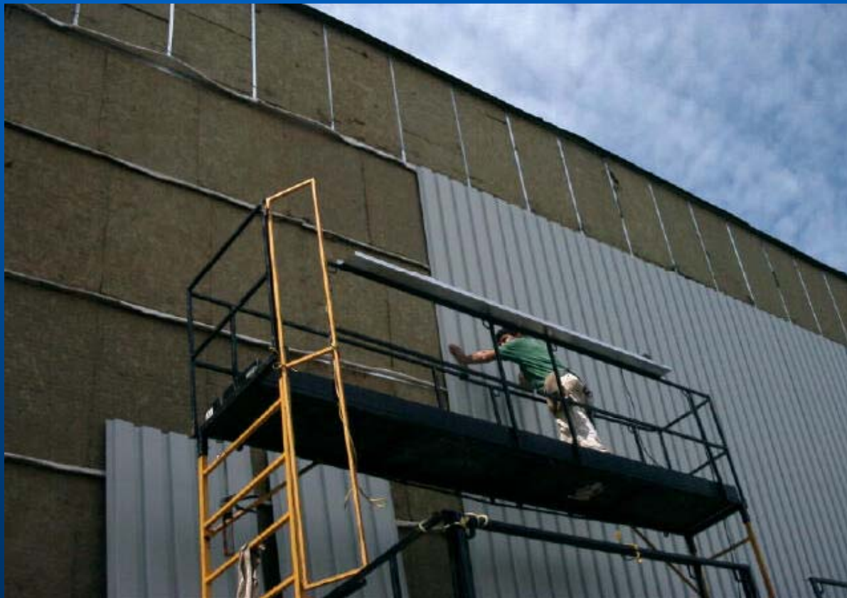
Mur sandwich standard en cours d'installation
