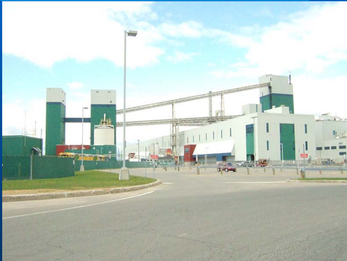
Aluminerie Alcan à Alma - utilise du revêtement nervuré en aluminium – évidemment!
