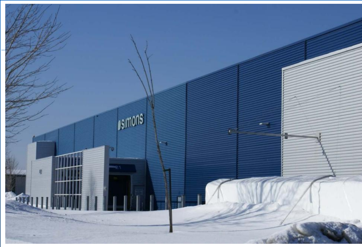
Revêtement métallique nervuré posé horizontalement
