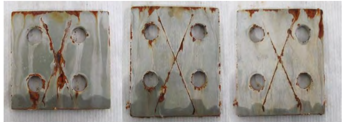
Pièces du pont de Québec
